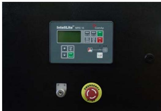
自动化机组控制屏是无人值守自动化机组最基本的配置。该屏能接收远程开/停机组控制信号。(ATS 控制) 功能特点：采用捷克科迈 Comap 智能控制器；大屏幕液晶显示器；全中文（也可英文）操作、显示菜单；机组具有自动、手动、关机（急停）等控制功能，丰富的可编程输出、输入接口及人性化界面，多功能液晶显示器，将检测的参数通过数据、符号、直条图显同时显示；标准的通讯接口：RS-232（Modbus 通讯协议），满足用户通过通讯（网络）或中央监控系统（上位机）对机组实现“遥控”、“遥测”、“遥报”等监控功能，可满足各种自动化机组的需要。
